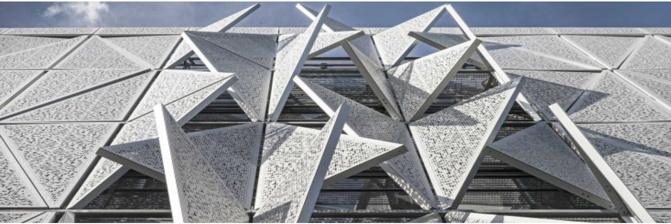
Рисунок 12 - Подвижные панели на фасаде здания университета Южной Дании
