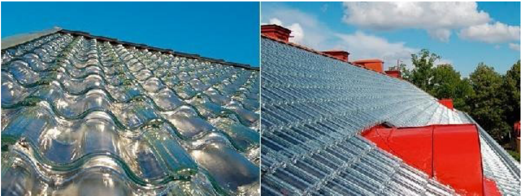
Рисунок 46 – Кровля из стеклянной черепицы
