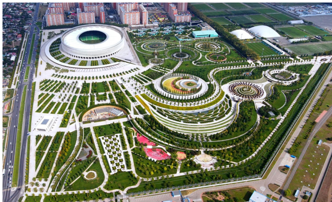
Рисунок 58 - Строительство стадиона «Краснодар» (Краснодар)
